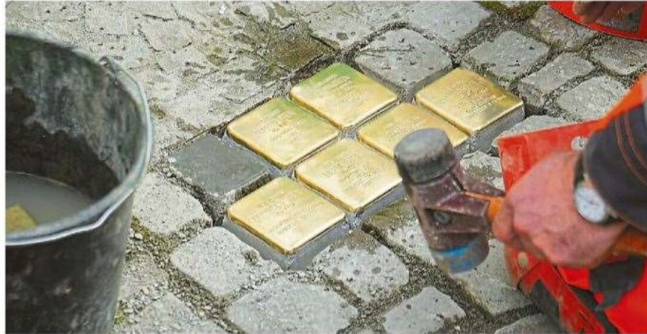
Mitarbeiter des Bauhofs verlegen Stolpersteine vor dem Haus mit der Adresse Münsterstraße 2: Dort hatten Anna Stein, Alfred Stein, Berthold Stein, Herta Stein, Julia Stein und Hannelore Stein ihren letzten freiwilligen Wohnsitz. Foto: Stephanie Sieme
